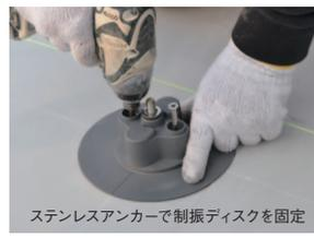
ステンレスアンカーで制振ディスクを固定
