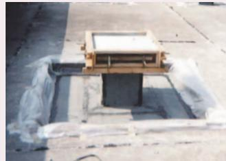
コンクリート基礎設置工事の防水層切断
