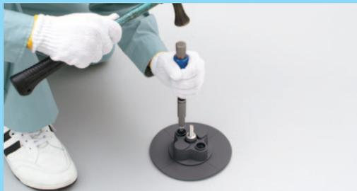
連結ディスクを下地へアンカー固定
