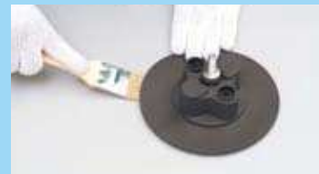
連結ディスクをリベットルーフと溶融着接合
