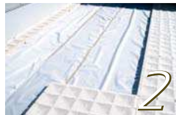
2. 絶縁シートを敷設し、PG保水排水ボード敷設
