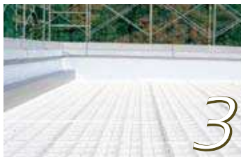
3.PG保水排水ボード敷設完了
