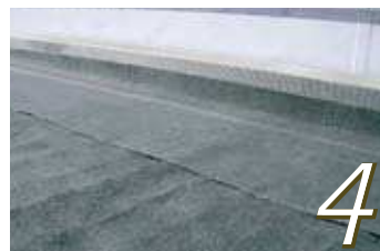
4.PGフィルターマット敷設
