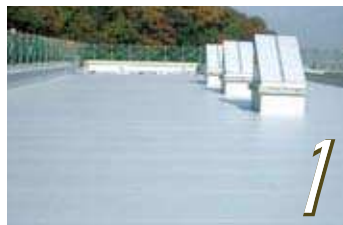
1.リベットルーフ施工
