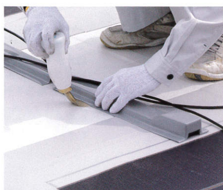
5.ジャンクションカバーの溶融着固定
