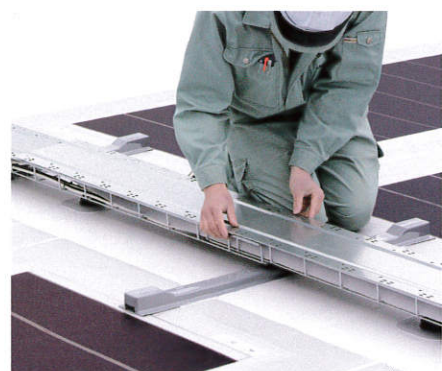
10.ケーブルラックカバーの敷設
