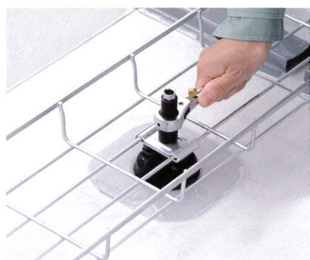
7.ケーブルラックと固定治具の緊結
