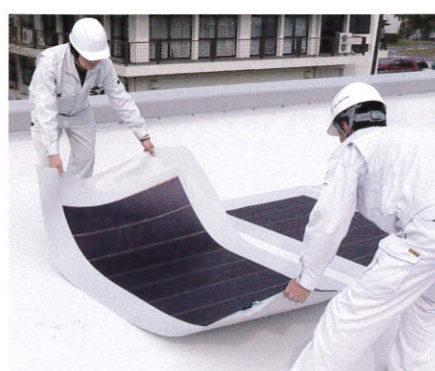
2.清掃・墨出後、シートを仮敷き
