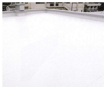
1.リベットルーフ防水工完了
