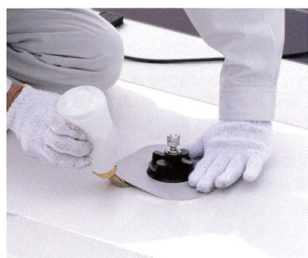
4.連結ディスクPVCを溶融着固定
