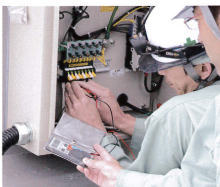
11.ストリングス毎の開放電圧測定
